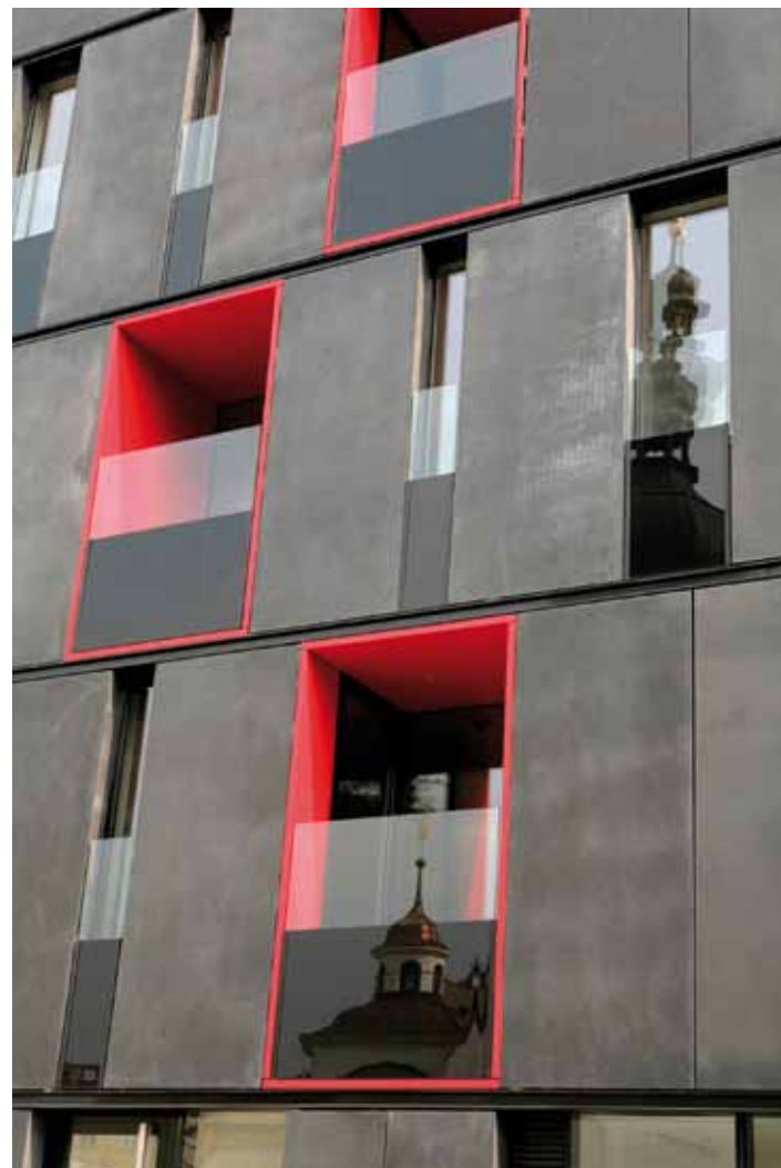
3 Na obklad fasády včetně lodžii jsou použity sklovláknobetonové prefabrikované desky; skleněné zábradlí slouží současně jako parapetní panel.
